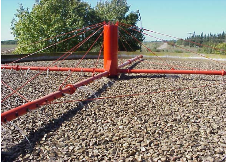
Foto de la superficie de un lecho percolador de piedra como material fijo y distribuidor hidráulico
