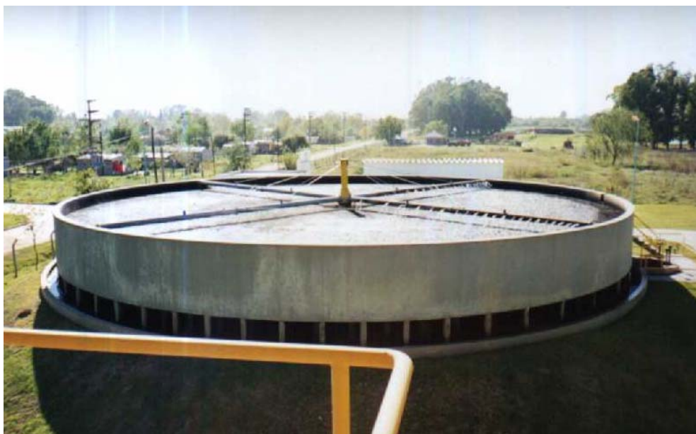
Vista completa de un lecho percolador. Obsérvese el brazo distribuidor hidráulico y las ventanas en el inferior del equipo que permiten la ventilación del lecho.
